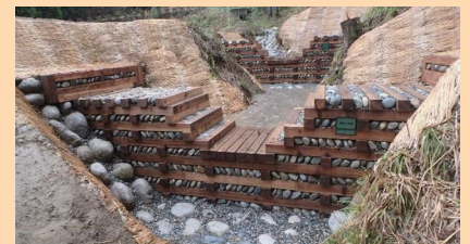
上下流に2基連続して木製ダムを配置して荒廃溪流を安定化 (魚津市)
